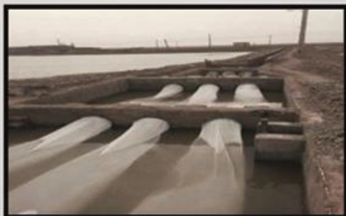
تصویر ۱۴- استفاده از فیلتر های مناسب و متعدد جهت تصفیه فیزیکی آب
